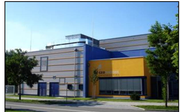
Bild: Geothermie Unterhaching
