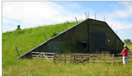
Die noch heute vorhandenen acht Munitionsbunker wurden möglicherweise von den Amerikanern gebaut. Außerdem existieren mehrere unterirdische Treibstoffbunker.
