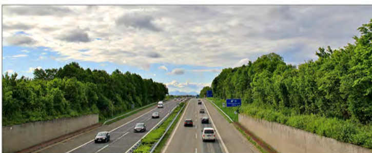
Ab in den Süden: Blick von der Autobahnhunterführung auf die A8.
