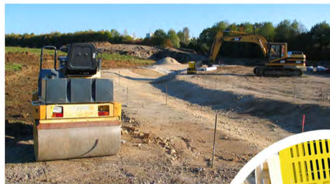
Das neue Bachbett wird ausgebaggert.
