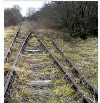
Gleise führen vom Bahnhof Neubiberg zu den Treibstoffbunkern und vom Bahnhof Perlach zu den Versorgungsgebäuden. Verschiedene Schienen tragen das Gusszeichen amerikanischer Hersteller von 1939.
