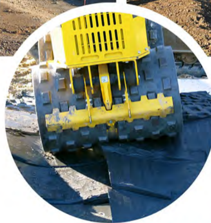
Mit einem Vlies sowie mit Lehmziegeln wird das Bachbett abgedichtet.
