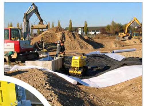
Mit einem Vlies sowie mit Lehmziegeln wird das Bachbett abgedichtet.
