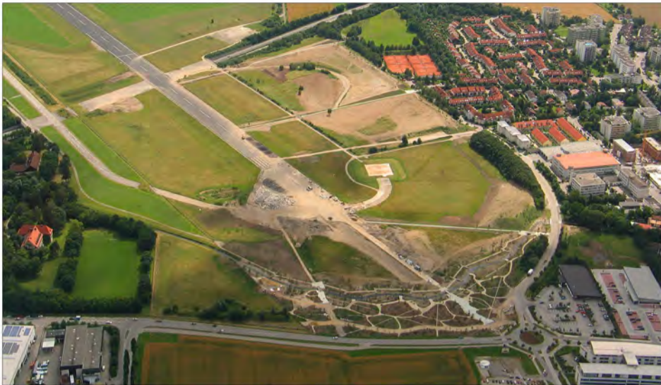
Der im Umbau befindliche Westteil des Landschaftsparks. Während die Schollen noch weiter aufgeschüttet werden, fließt der Hachinger Bach bereits in seinem neuen Bett. Auch das neue Wegenetz des angrenzenden Parks ist schon fertig gestellt.
