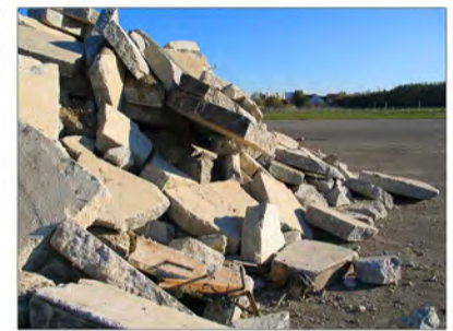
Alte Betonbeläge werden entfernt und zu Schutthaufen aufgetürmt.
