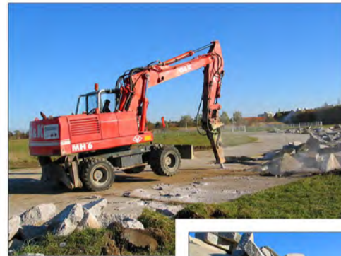
Alte Betonbeläge werden entfernt und zu Schutthaufen aufgetürmt.
