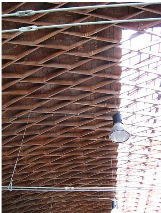
Abbildung 4: Dach der Halle in Zollinger-Kon-
